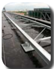
Рейковий шлях, прокладений на з/б або сталевій плиті
