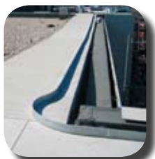
Бетонний шлях з напрямним кутником
