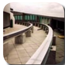
Рейковий шлях, закріплений на бетонних або сталевих опорах
