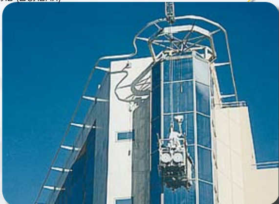
Моторизована люлька, підвішена до пересувної каретки на монорейці, Марокко (Марокко)
